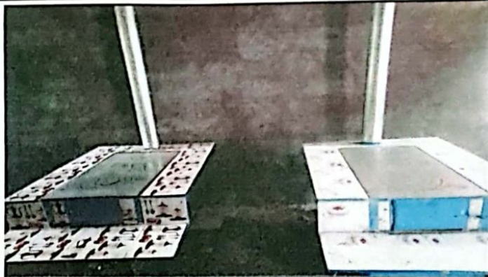
Foto 2: Sustitución de planchas.
