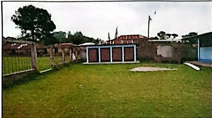
Foto 1: Bajante de agua pluvial y sustición de lamina a rotoplas.
