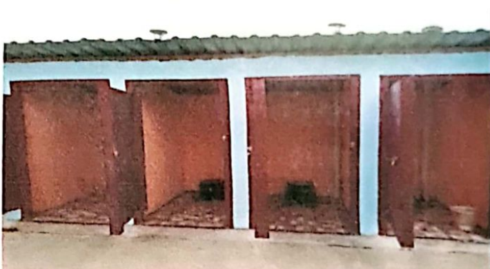
Foto 4: Piso ceramico a los sanitarios.
