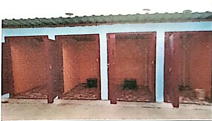
Foto 4: Piso ceramico a los sanitarios.
