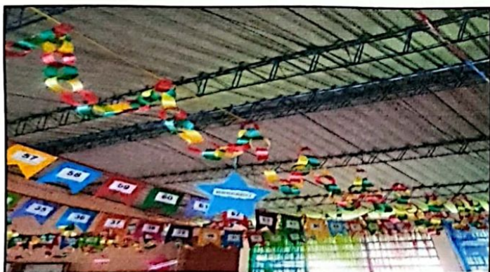
Foto 5: Sustitución de lamina.
